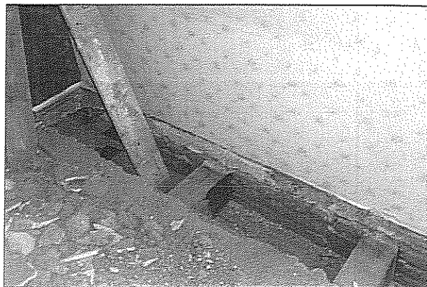
obr.č. 2: pohled na uložení stropních trámů v pásové sondě
